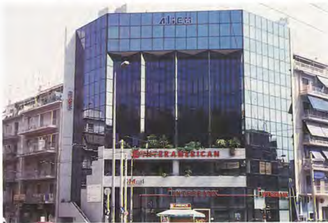
Κτίριο γραφείων στη γωνία Λεωφόρου Κηφισίας και Πανόρμιου, στους Αμπελόκηπους. Αρχιτέκτων Στέλιος Αγιοστρατίτης. Το κτίριο αυτό διακρίνεται γιατί μεγιστοποιεί μικρο-πολεοδομικές επιδιώξεις (ένταξη, στρίψιμο γωνίας κ.τ.λ.) όσο και αρχιτεκτονικές (κλίμακα και λιτότητα του στερεοπλαστικού του), αντιμετωπίζοντας τα πάντα συνθετικά (σήμανση-ταμπέλες) σε ένα δύσκολο και μικρό οικόπεδο.
