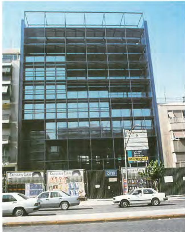
Κτίριο γραφείων ΓΕΚ Ψυχτικής, στη Λεωφόρο Αλεξάνδρας. Αρχιτέκτων Αλέξανδρος Τομπάζης και συνεργάτες. Προσπάθεια με έκδηλες προθέσεις αντιμετώπισης της όψης σαν ένα ανεξάρτητο συνθετικό πλαίσιο λειτουργίας (έναν "τοιχώ που αναπνέει - ευέλικτη όψη"), που υπακούει στους νόμους των αναλογιών, με νέα υλικά και τολμηρό (για τα καθ' ημάς), αλλά ευπρόσδεκτο, χρώμα.
