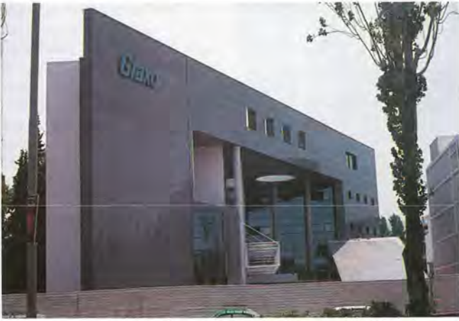
Κτίριο γραφείων εταιρίας Glaxo, στη Λεωφόρο Κηφισίας στο Ψυχικό. Αρχιτέκτονες: Κ. Κυριακίδης και Συνεργάτες Α.Ε. Τ. Εξαρχόπουλος - Γ. Αποστολάκος. Υψηλό δείγμα μοναδικότητας και μιμιμαλιστικής μορφολογίας στον τόπο μας (για περισσότερα βλέπε άρθρο για Κυριακίδη).
