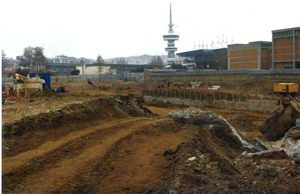
Εργασίες Θεμελίωσης του Νέου Δημαρχιακού Μεγάρου στο Στρατόπεδο Τσιρογιάννη
